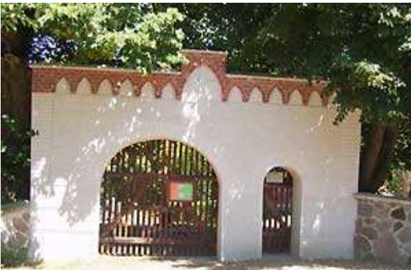
Der Friedhof ist von einer Steinmauer mit Portal umgeben. Ein Gedenkstein erinnert an die Gefallenen des ersten Weltkrieges. Das Kirchhofportal mit einem großen und einem kleineren Tor ist vermutlich am Ende des 16. Jahrhunderts mit Backstein gebaut und mit einer Putzquaderung versehen worden. Der neugotische Spitzbogenfries wurde Ende des 19. Jahrhunderts angebracht.
